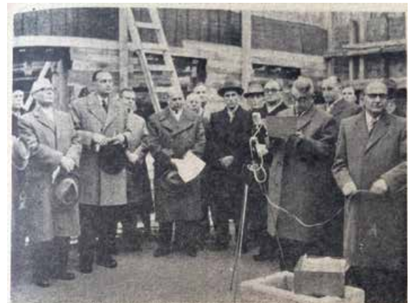
Grundsteinlegung zum „Haus der Bessarabiendeutschen“
