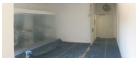
Ein großer Raum wird die zukünftigen Besucher empfangen, die Wand zwischen Flur und Raum 1 ist seit dem 12. Oktober Geschichte
