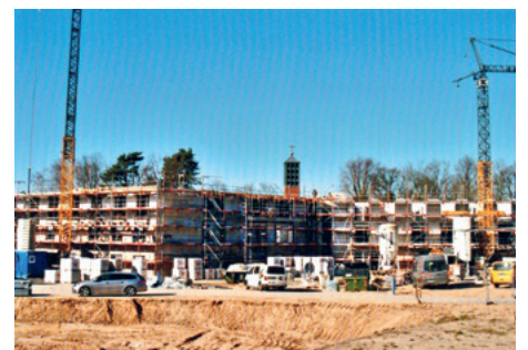
Und so einen Fortschritt hat das Bauprojekt zum Sommer 2025 gemacht
