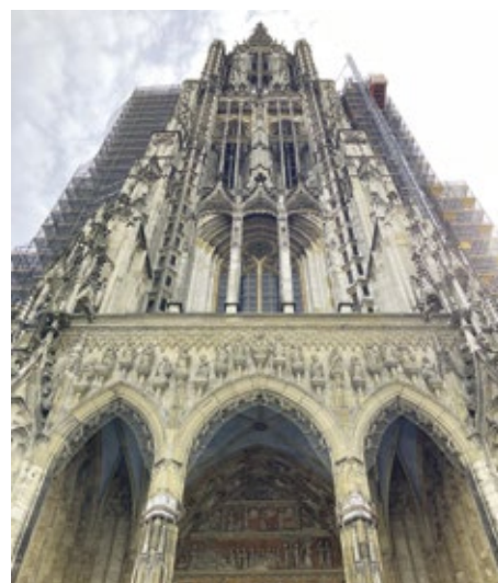
Steiler Blick zum höchsten Kirchturm der Welt, unten das Hauptportal des Ulmer Münsters
