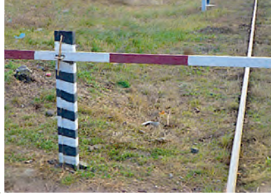
Beschränkter Bahnübergang, gesichert mit dünnem Holzstecken
