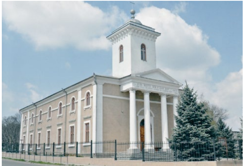
Die Kirche in Sarata nach der Wiederherstellung 1995
