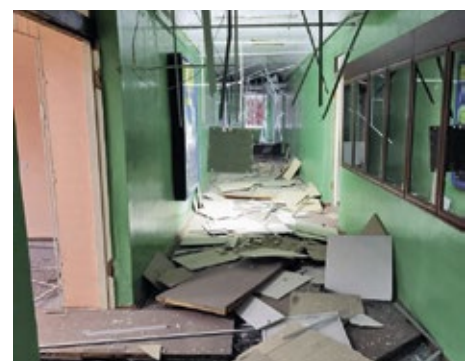
... zerstörte Deckenverkleidungen ...
