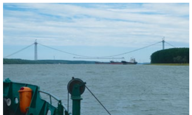
Die neue Donaubrücke im Entstehen
