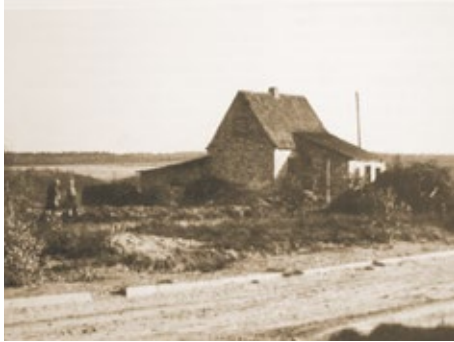
Erstes behelfsmäßiges Siedlungsbaus aus Trümmersteinen in der späteren Königsberger Straße der Heidesiedlung 1951. Erbaut von Erich Hinz aus Rosenberg/Westpreußen und seiner Ehefrau Elfriede Hinz, geb. Tarnaske aus Tarutino/Bessarabien.
