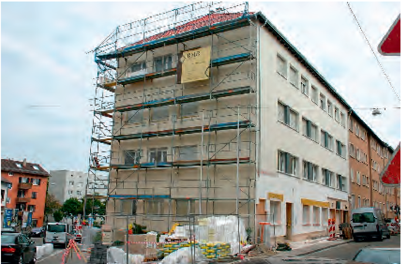
Hier tut sich was! Der Umbau und die Renovierungsarbeiten am Heimathaus geben zügig voran.
