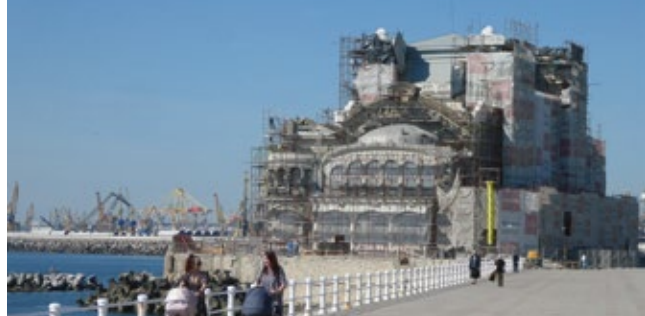
Casino Constanza in der Restaurierung
