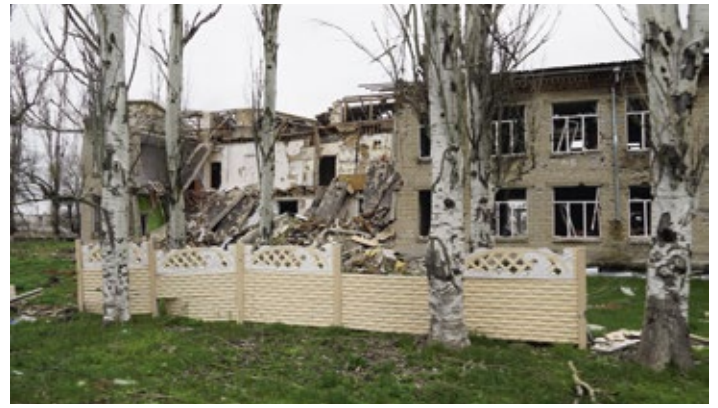
In weiteren Lieferungen will Emstal hilft schweres Gerät zur Beseitigung der Ruinen liefern
