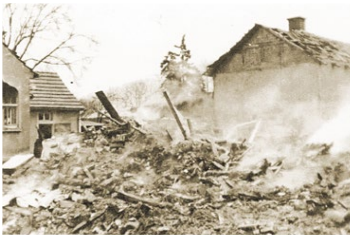
Die größte Katastrophe in der neuen Heimat: Gasexplosion des Wohnhauses Janke im Dezember 1965
