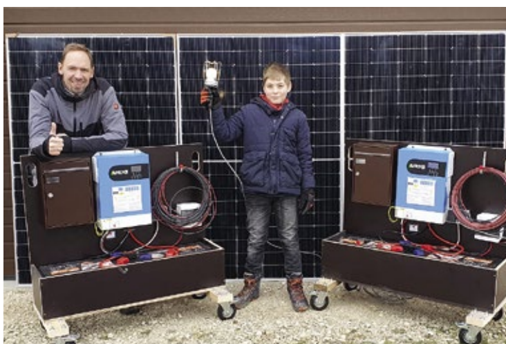
Jochen Hantschel aus Dettingen, mit seinem Sohn, hat für Ermstal-Hilft die Solaranlage gebaut
