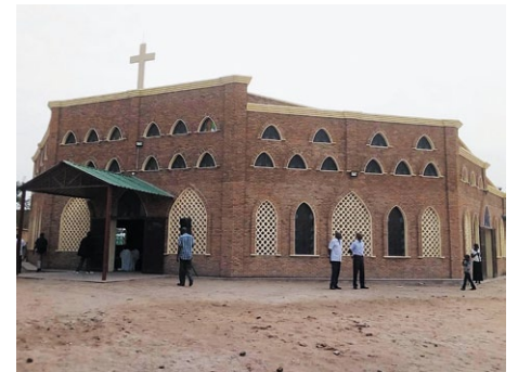
Kirche nach der Erweiterung (Foto 2)
