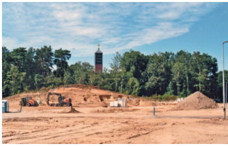
Baugebiet der zukünftigen Tarutinoer Straße bei der Lutherkirche im Sommer 2024
