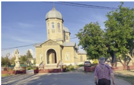
Die Kirche von Neu-Strymba war 1994 noch eine stillgelegte Baustelle
