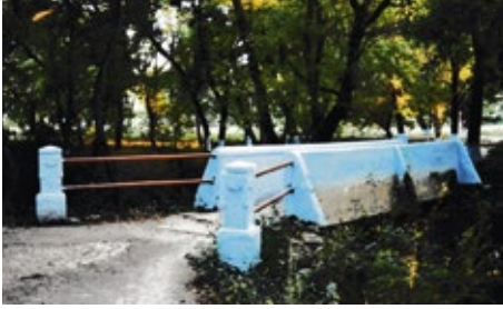
Kirchenbrücke von Gustav Tarnaske, Foto von 2014
