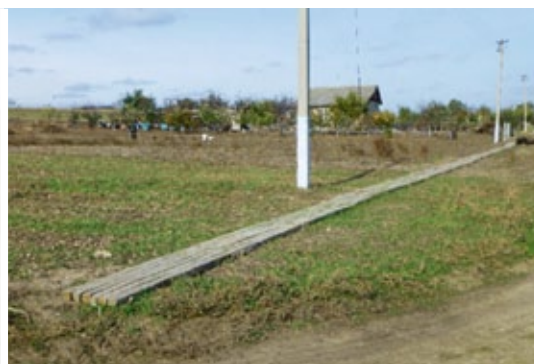
Mit Betonbalken ausgelegter Gehweg zu Häusern in Kurudschika
