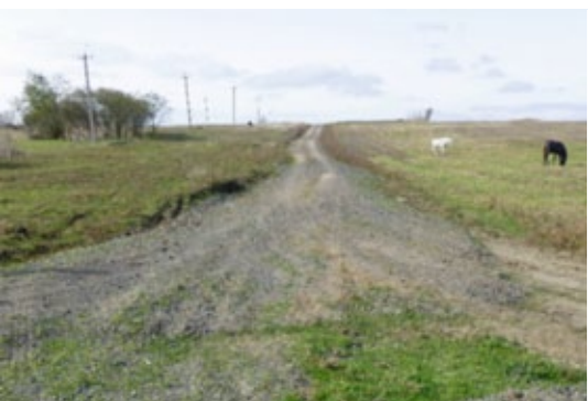
Der geschotterte Weg in Kurudschika über den Höhenrücken
