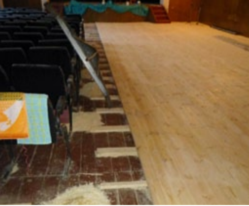
Der halbfertige Boden im Theatersaal im Kulturhaus in Peterstal
