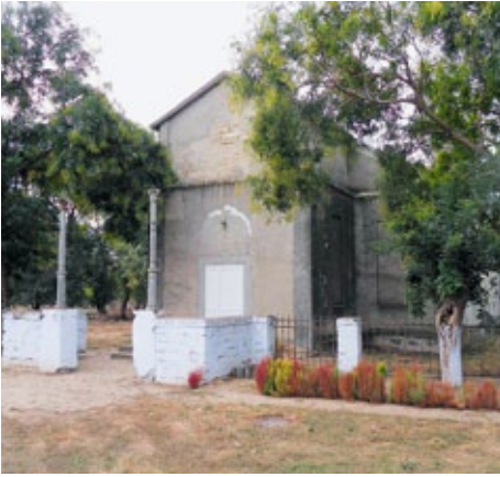
Der traurige Anblick der ehemaligen Kirche in Katzbach, erbaut in den Jahren 1893-94
