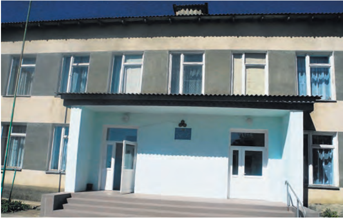
Schule in Borodino - Neuer Eingangsbereich finanziert über unsere Bessarabienhilfe
